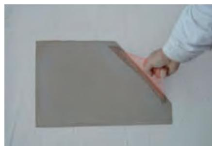
*Applicazione di una rasatura armata su di una porzione di 30x30 cm con il collante del sistema*
