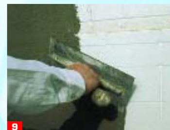
Dopo la formazione dello strato di malta rasante si procede alla posa della rete di armatura in fibra di vetro WALER RETE WTG 43 da 150 g/m<sup>2</sup>, che viene **annegata nello strato di malta rasante ancora fresca** (→Fig.10).
