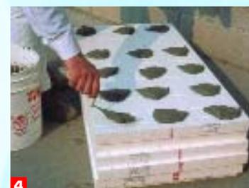
Per il sistema WALER SICURWALL è previsto l'impiego di materiale isolante in pannelli di polistirene espanso sinterizzato PANNELLO THERMOWALL da 15/20 kg/m<sup>3</sup> nelle dimensioni 100 x 50 cm, fresati opportunamente sulle due facce per garantire l'adesione migliorata della malta cementizia.
