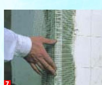
secondo le modalità previste dalla scheda tecnica. L'applicazione viene eseguita con spatola liscia in acciaio per uno spessore medio di almeno 2,0 mm.
