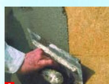
di armatura in fibra di vetro **WALER RETE WTG 43** da 150 g/m<sup>2</sup> (→Fig.10), annegando la stessa nello strato di malta rasante ancora fresca.
